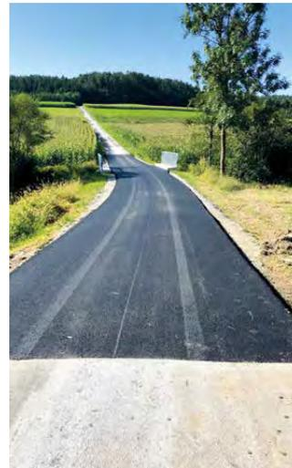
Im Zuge der Errichtung der Abwasserentsorgung 2018 wurde gleichzeitig der gesamte Unterbau des Weges erneuert. Im Sommer 2019 wurde die Oberflächenwasserentsorgung des Weges erneuert und die Sanierung des Weges mit der Asphaltierung abgeschlossen.
