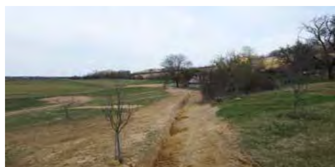
Neuanlage eines Entwässerungsgrabens
