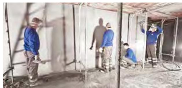
Beschichtungsarbeiten bei einem Trinkwasser-Hochbehälter
