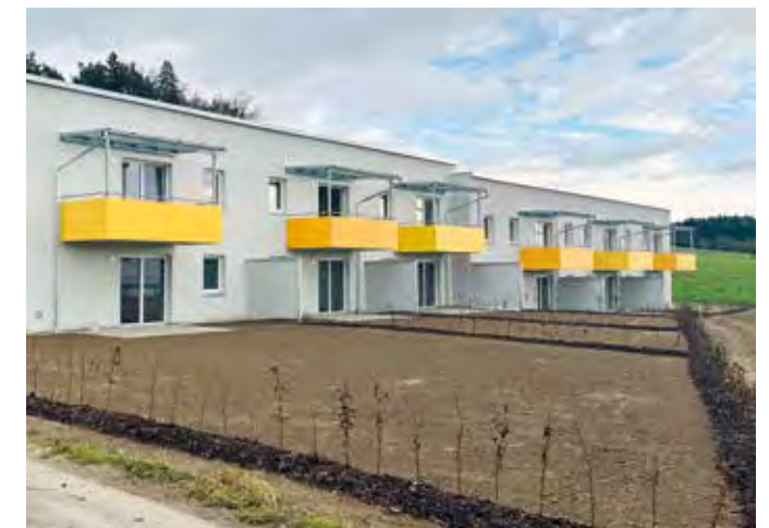
Die neuen Bewohner sowie Ehrengäste freuen sich über die Fertigstellung der Rottenmanner-Wohnanlage in Ebersdorf.
